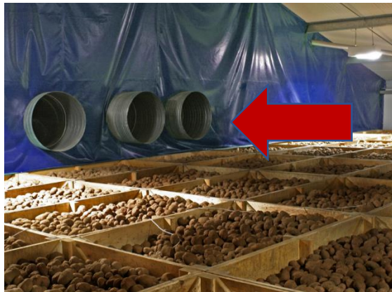
Abbildung 5&6 Belüftungs- und Kühltechnik mit Luftverteilereinrichtung im Kistenlager
